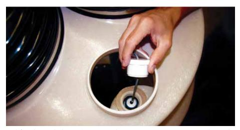
Pie de foto: El puerto de observación es un punto de acceso conveniente para inspeccionar el sensor de monitoreo en los modelos de sumidero de pared doble y realizar una inspección visual del interior del sumidero.
